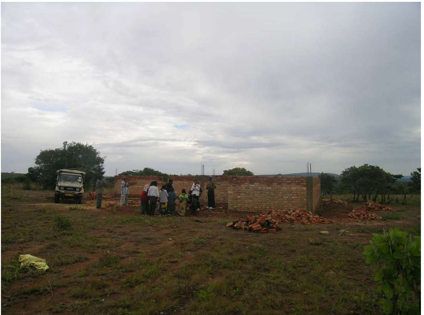
Sopralluogo lavori asilo di Ihongole Novembre 2008
